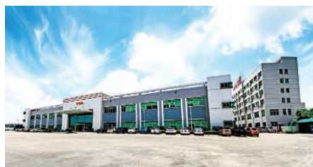
Jiujiang Base (2 εκ. σετ κλιματιστικών)
