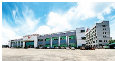
Jiujiang Base (2 εκ. σετ κλιματιστικών)
